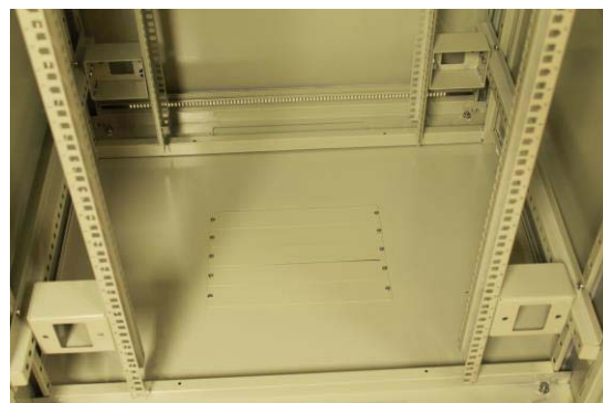
Przepusty kablowe w podstawie szafy
