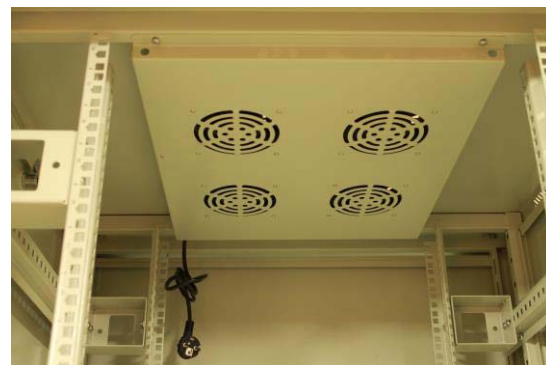
Panel wentylatorów zamontowany w suficie
