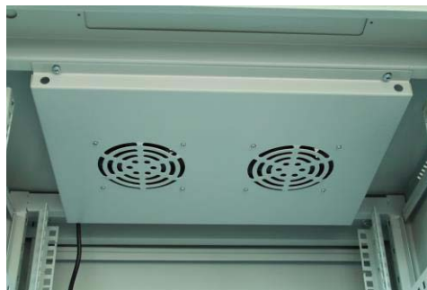
Panel wentylatorów zamontowany w pokrywie górnej
