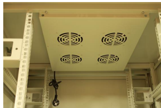
Panel wentylatorów zamontowany w suficie
