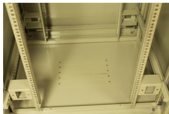
Przepusty kablowe w podstawie szafy
