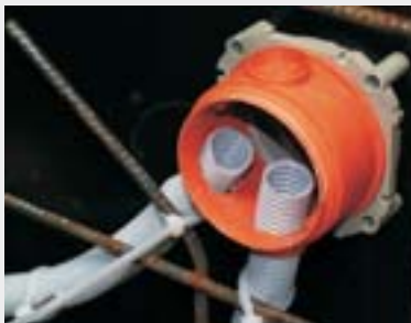
Zamontowane rury giętkie do korpusu KBT.
