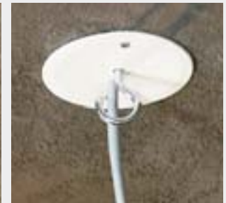
Puszka elektroinstalacyjna KBT... zakryta wieczkiem V 68 S z wyprowadzonym przewodem i hakiem oświetlenia KBP...
