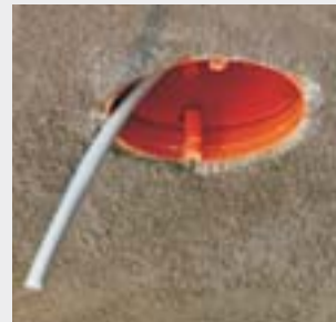
Puszka elektroinstalacyjna KBT... z wyprowadzonym przewodem przygotowana do montażu haka oświetlenia KBP...
