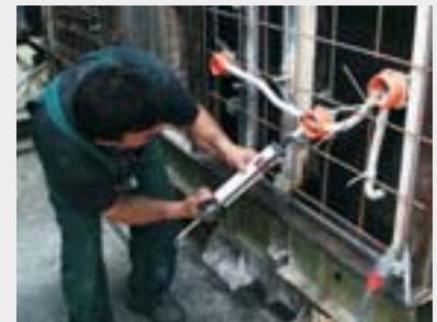
Uszczelnianie przepustów (kit).
